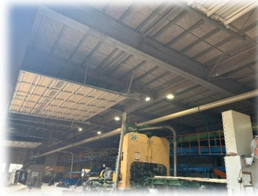
令和7年4月 製材工場照明設備整備(LED化)
